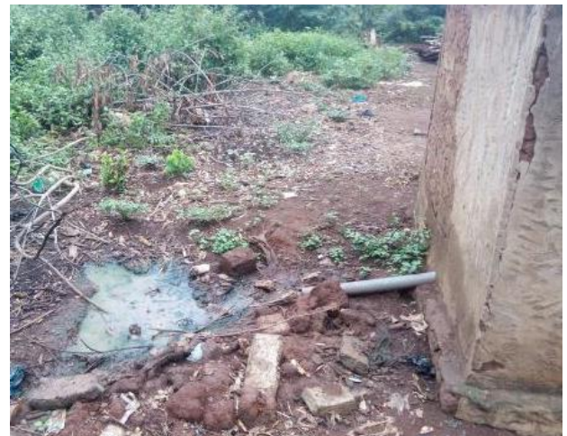
Photo 13 : eaux usées d'une douche, à l'arrière d'une cour
