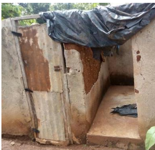
Photos 14 et 15 : latrines VIP et en dur.
